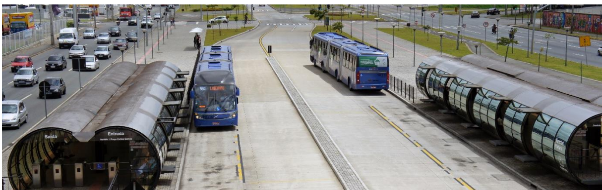
Figura 53: Estação Marechal Floriano, com vias dedicadas para BRT (cidade de Curitiba, Brasil). Fonte: pt.wikipedia.org, 2015.
